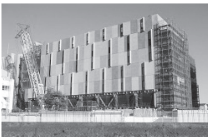
川向うから実験棟1 (2021/12/28)
