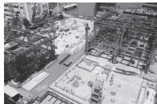
実験棟1、実験棟2 地上鉄骨建方 (2021/8/3)
