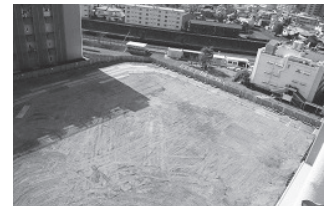
第1建物・第4建物 解体工事完了 (2021/2/13)
