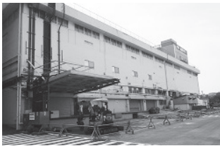
第1建物 西側プラットフォーム 庇撤去 (2020/7/18)
