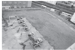
第1建物 基礎解体中 (2021/1/5)
