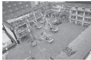
第1建物 解体中 (2020/10/23)
