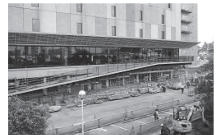
実験棟1 2階食堂及びスロープ (2022/4/28)
