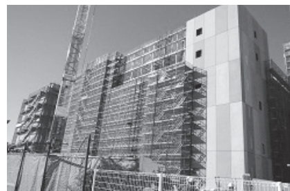
東側市道から実験棟2 (2021/12/28)
