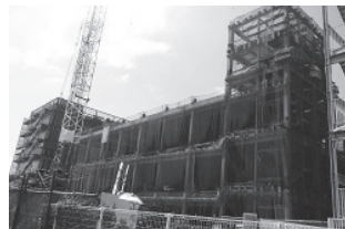
実験棟2 建設中 (2021/9/27)
