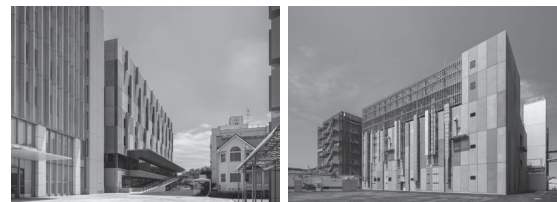
藤沢テクノセンター 実験棟(左:第103建物、右:第104建物)
