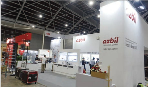
デザインガイドラインに基づいて展示ブースを施工。写真はITAP (Industrial Transformation ASIA PACIFIC, シンガポール)での施工風景
